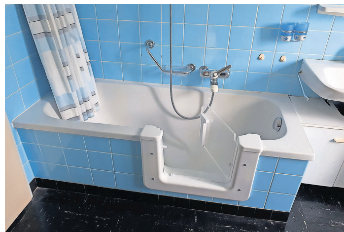
Eine Badewannentür kann in kurzer Zeit in eine bestehende Wanne eingebaut werden.
